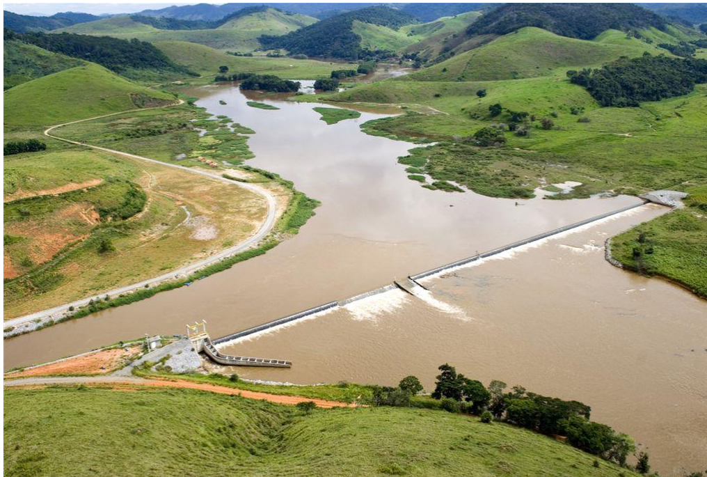
Figura 1 – Vista geral das estruturas da Barragem Vertente (Estrutura de Desvio), com vazão sanitária e escada de peixes, da PCH Santa Fé
