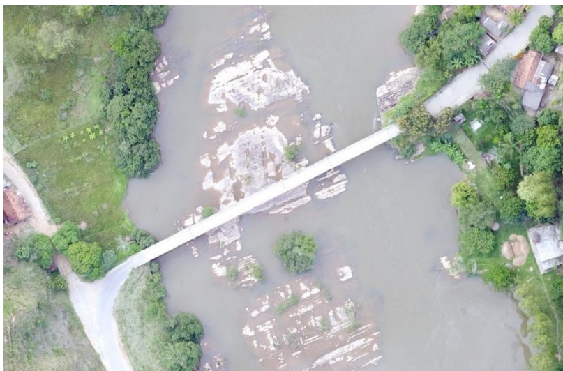
Figura 25 – Ponte 02 localizada entre os municípios de Chiador - MG e Três Rios – RJ
