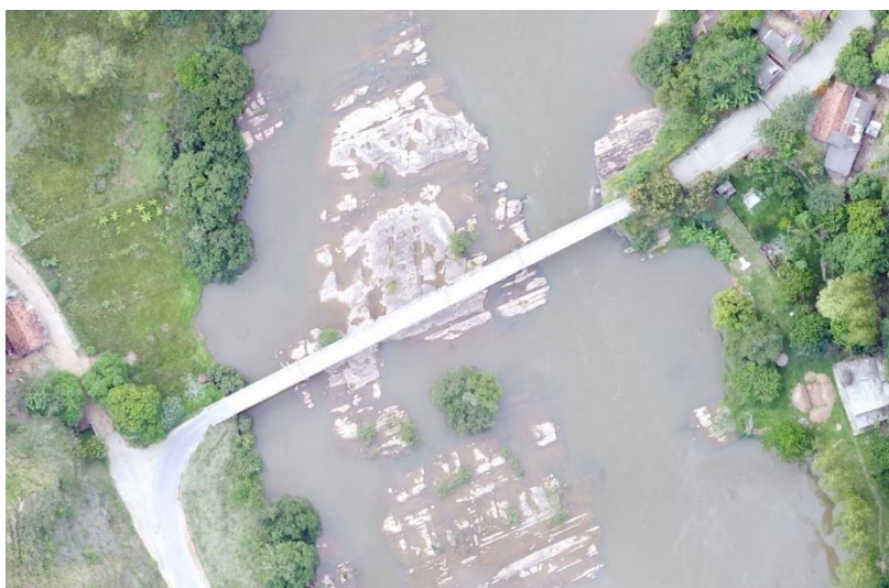
Figura 13 – Ponte 01 localizada entre os municípios de Chiador - MG e Três Rios – RJ
