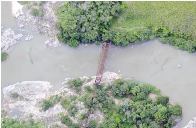
Figura 23 – Ponte 01 localizada entre os municípios de Chiador - MG e Três Rios – RJ
