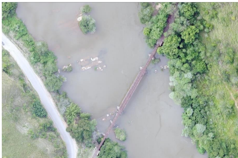
Figura 27 – Ponte 03 localizada entre os municípios de Chiador - MG e Três Rios – RJ
