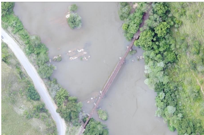
Figura 15 – Ponte 02 localizada entre os municípios de Chiador - MG e Três Rios – RJ
