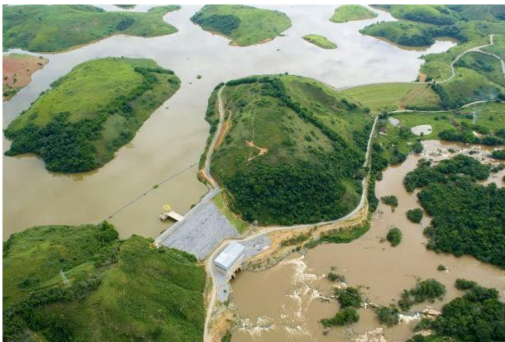
Figura 2 – Vista geral da casa de força, barragem principal e dique 1 da PCH Santa Fé
