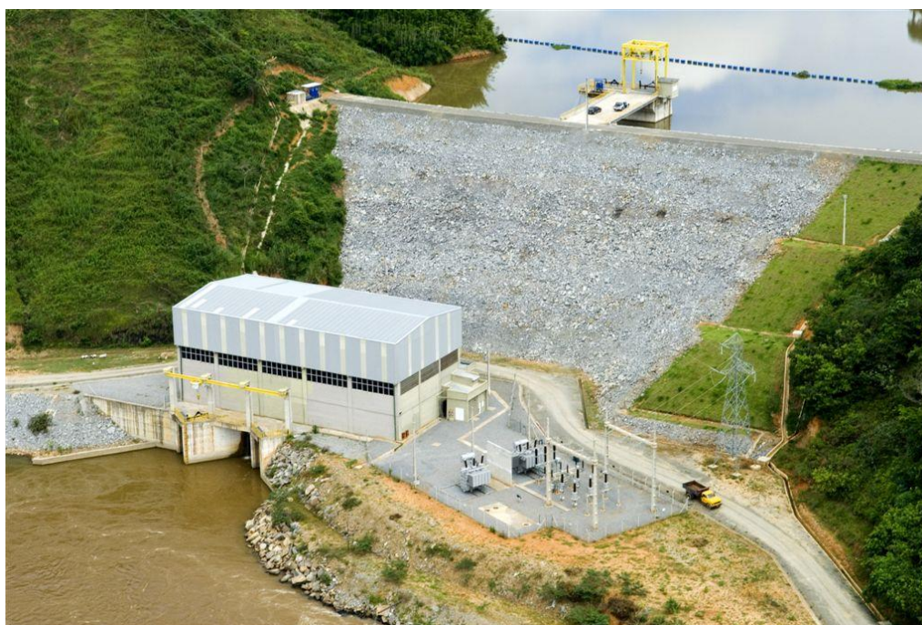
Figura 8 – Tomada D'água, Barragem principal, Casa de Força e Subestação da PCH Santa Fé
