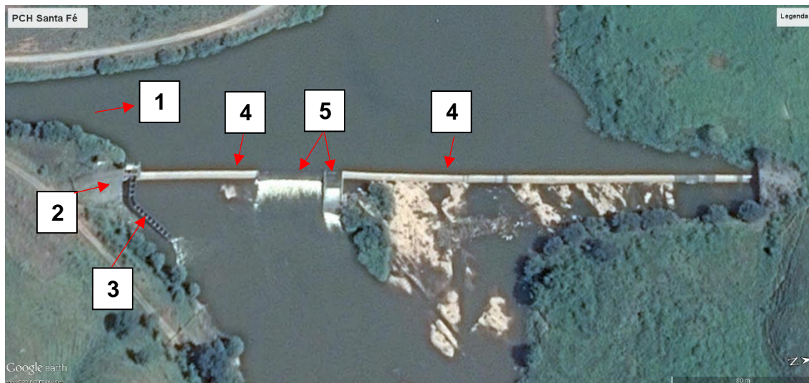
Figura 5 – Detalhe das estruturas da barragem vertente da PCH Santa Fé
